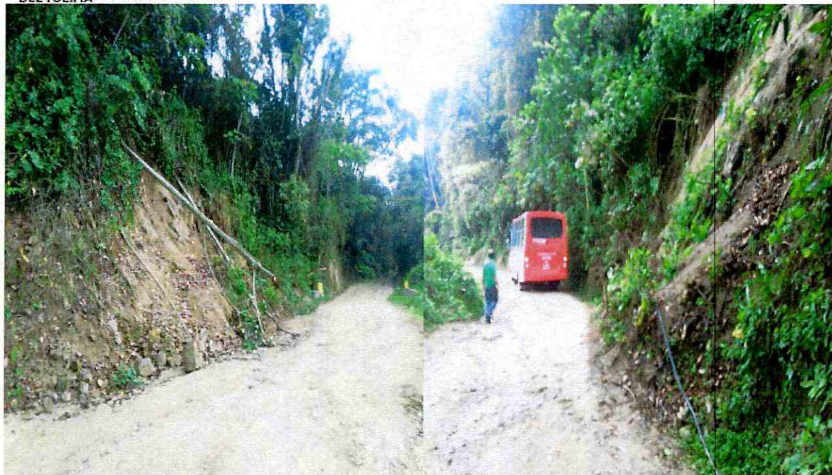
Visita técnica sobre los puntos a intervenir en la vía.
