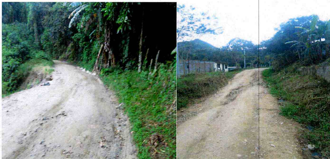
Visita técnica sobre los puntos a intervenir en la vía.
