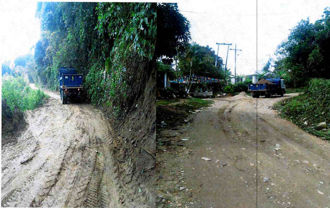
Actividades de mejoramiento vial.
